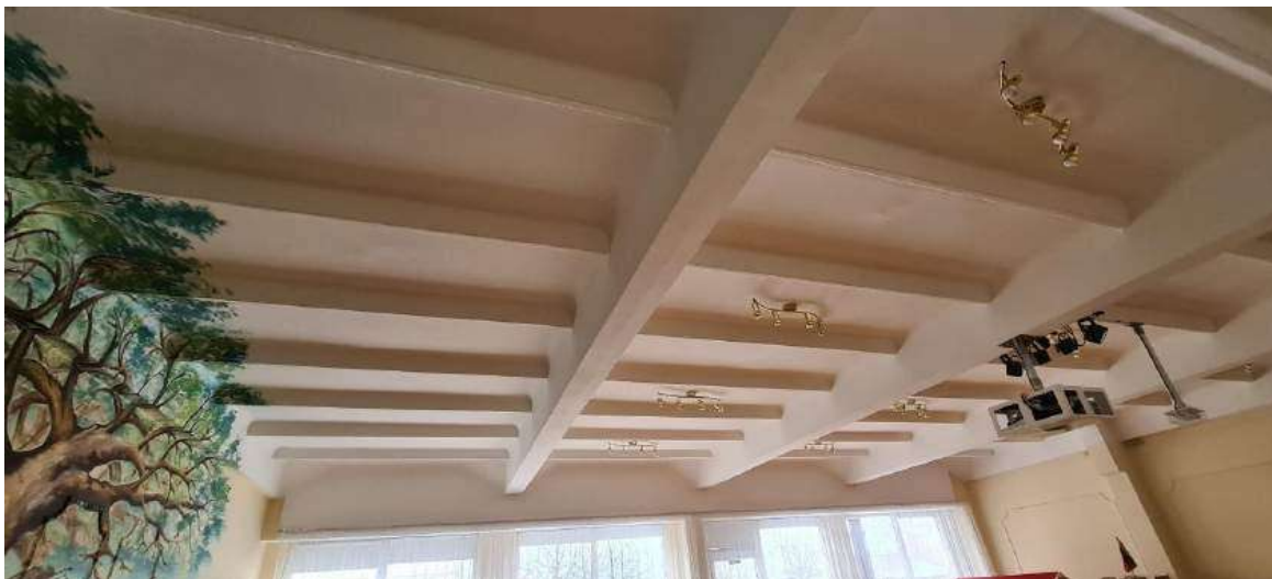
Nuotrauka Nr. 3 bendras statinio konstrukcijų aktų salėje
