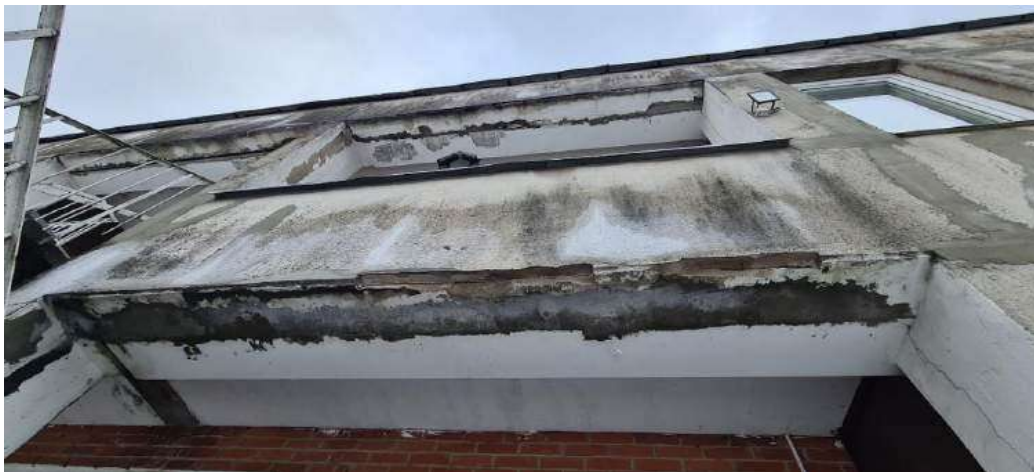
Nuotrauka Nr. 6 Fasadinių dujų silikato plokščių apatinėje dalyje nuo drėgmės ir šalčio poveikio nukritusi dalis dujų silikato, matoma koroduojanti armatūra
