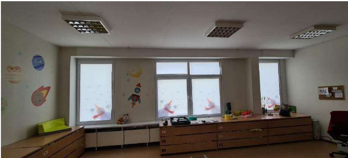
Nuotrauka Nr. 1 bendras statinio konstrukcijų vaizdas antrame aukšte
